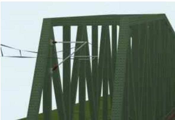
Halterung für die Oberleitung bei eingleisigen Brücken
