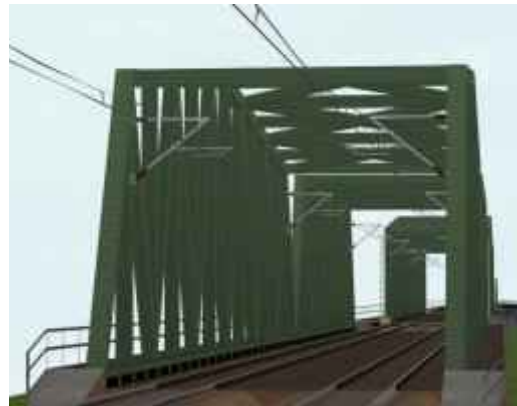
Halterung für die Oberleitung bei zweigleisigen Brücken
