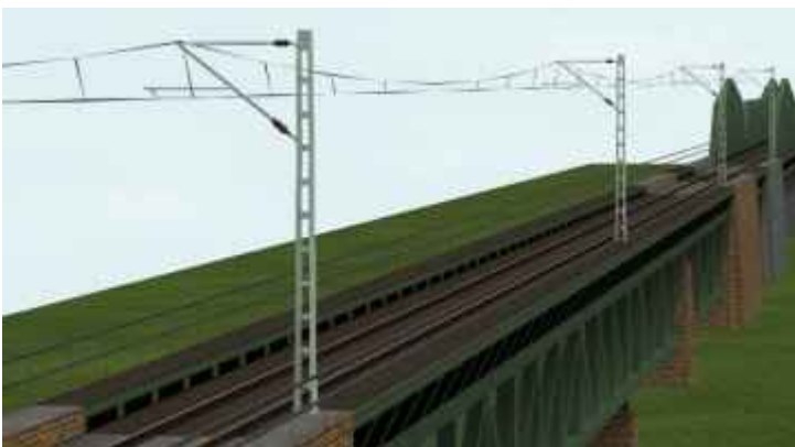
Brückenmasten für die Oberleitung
